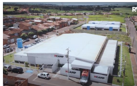
Figura 1. Hospital de Campanha de Rio Verde – GO
